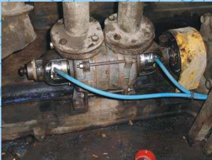
Уплотнения типа 22GF замонтированное в насосе S42DT „HYDRO-VACUUM”
