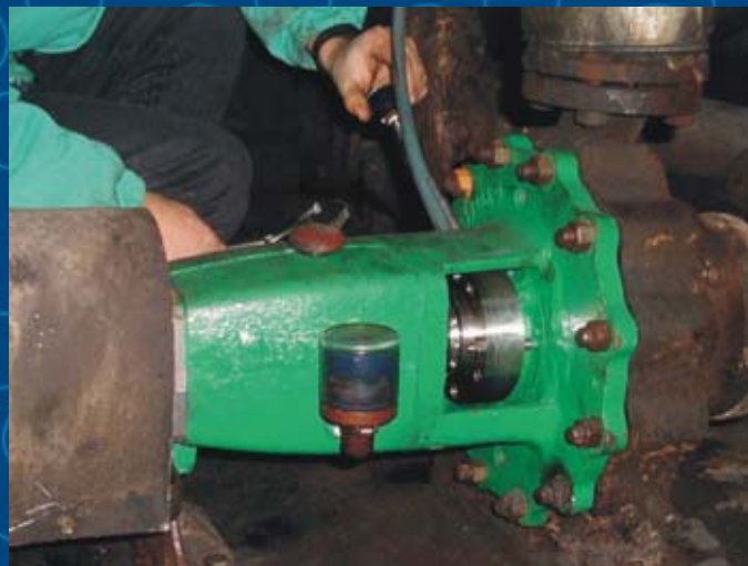
Уплотнения типа 45 GF установлено в насосе 5A25A „WAFAPOMP”
