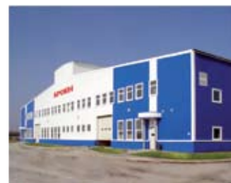
Производственный комплекс BROEN в Коломне
