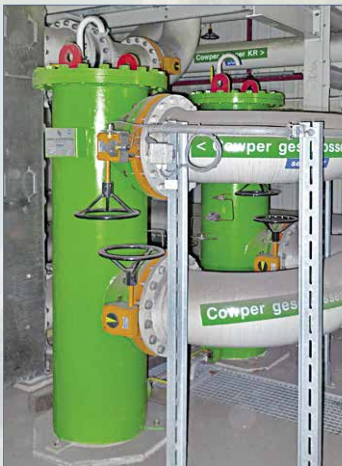
Рис. 2 Одинарный фильтр из стали на сварке.
