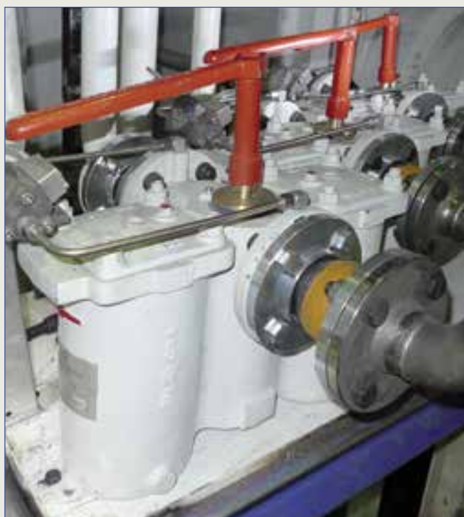
Рис. 4 Двойной фильтр, корпус – литьё.
