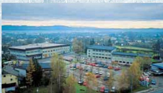
Завод I: Фёклабрук/Австрия
