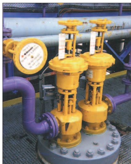
Клапан откр. / закр. Модель 2200 с устройством ручного управления – хранение сжиженного газа
