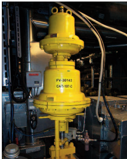
Сдвоенные приводы на теплоизолированном клапане
