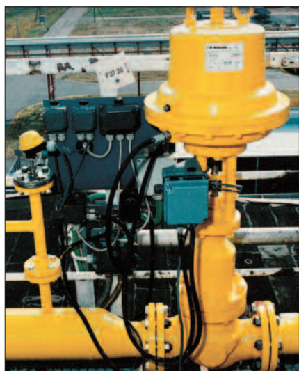
Регулирующий клапан Модель 2100BAC - цех хлора
