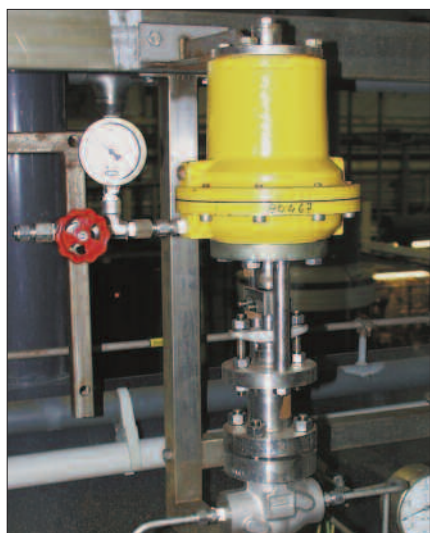
Клапан откр. / закр. Модель 2100В – линии тяжелой воды/гелия
